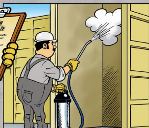
Odformovací nátěr nanes v tenké a rovnoměrné vrstvě.
