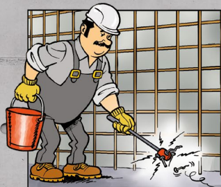
Vyčisti bednění (vysavačem, magnetem).
