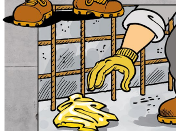
Odstraň všechny nečistoty a smetí z bednění.
